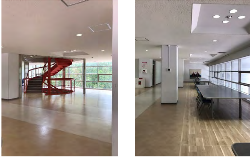
タイルカーペットの床を長尺シートに貼り替えています
