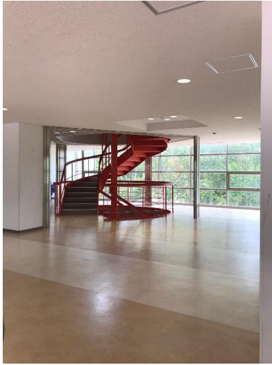
タイルカーペットの床を長尺シートに貼り替えています
