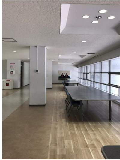
タイルカーペットの床を長尺シートに貼り替えています
