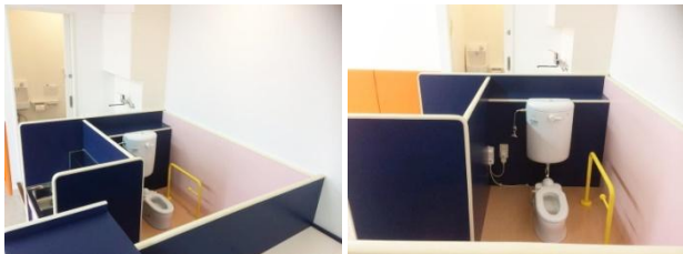
園児用WC（高さの低い仕切りパネルで）
